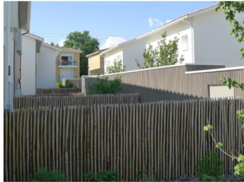
SAINTE-EULALIE (33), MAISONS EN BANDE, ATELIER MAZIÈRES ARCHITECTES LA DOUBLE RANGÉE DE GANIVELLE ASSOCIÉE AU GÉOTEXTILE DE COULEUR BRUNE PERMET DE CRÉER UN PARE-VUE DE QUALITÉ À MOINDRE COÛT.
